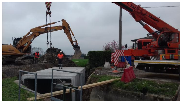
sostituzione ponte con manufatti (di ampia sezione)
