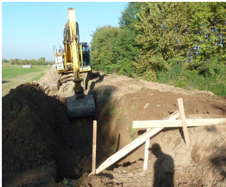
Lavori in corso sul Tesinella a Veggiano da parte del Consorzio
