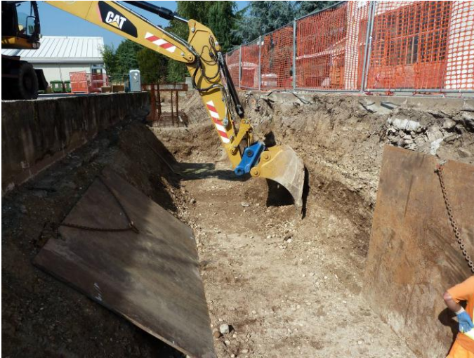
I lavori in corso nel torrente Lugana
