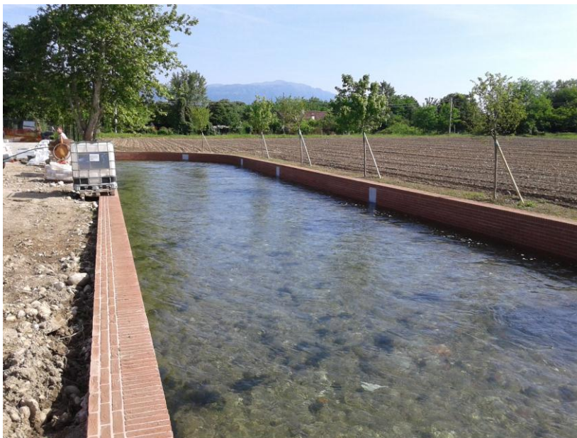
Veduta del tratto del canale a monte del partitore
