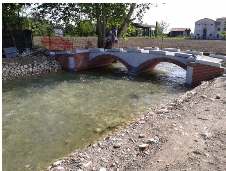
Veduta del ponte a doppio arco in fase di ultimazione
