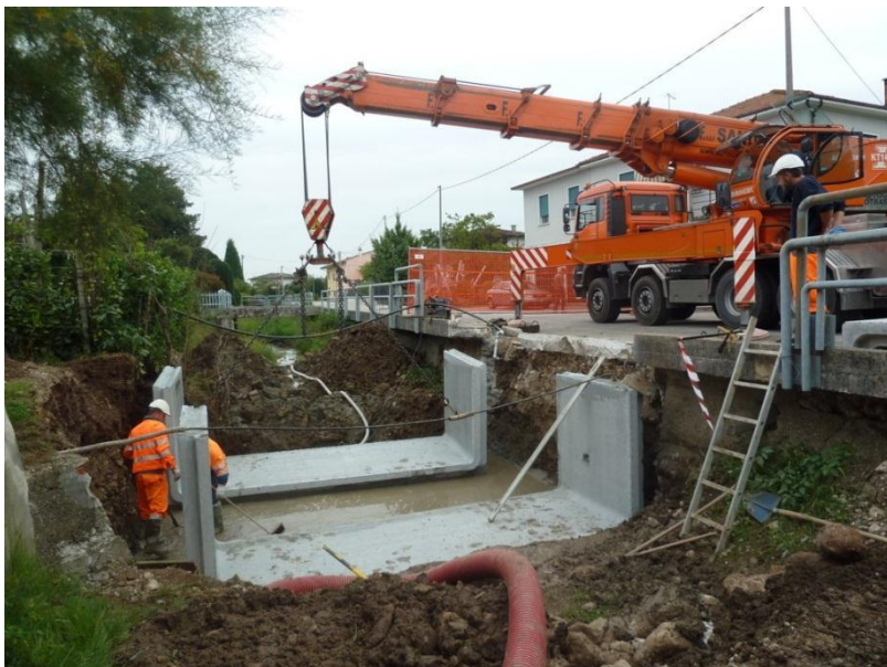
I lavori in corso nel torrente Ghebo Longhella
