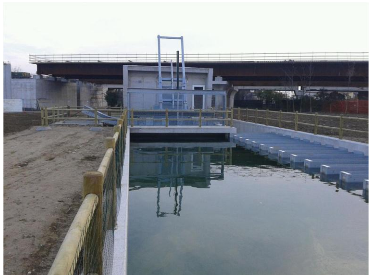
nuova centrale idroelettrica di Marchesane a Bassano
